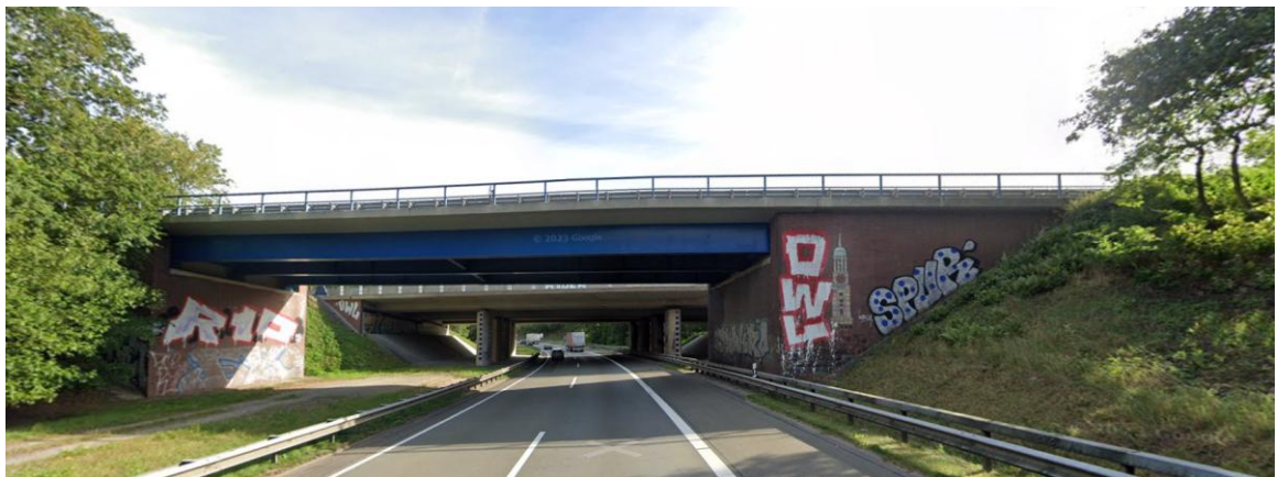
Abb. 3: Seitenansicht BW 434 (Quelle: Google Maps, Stand: 16.03.2026)
