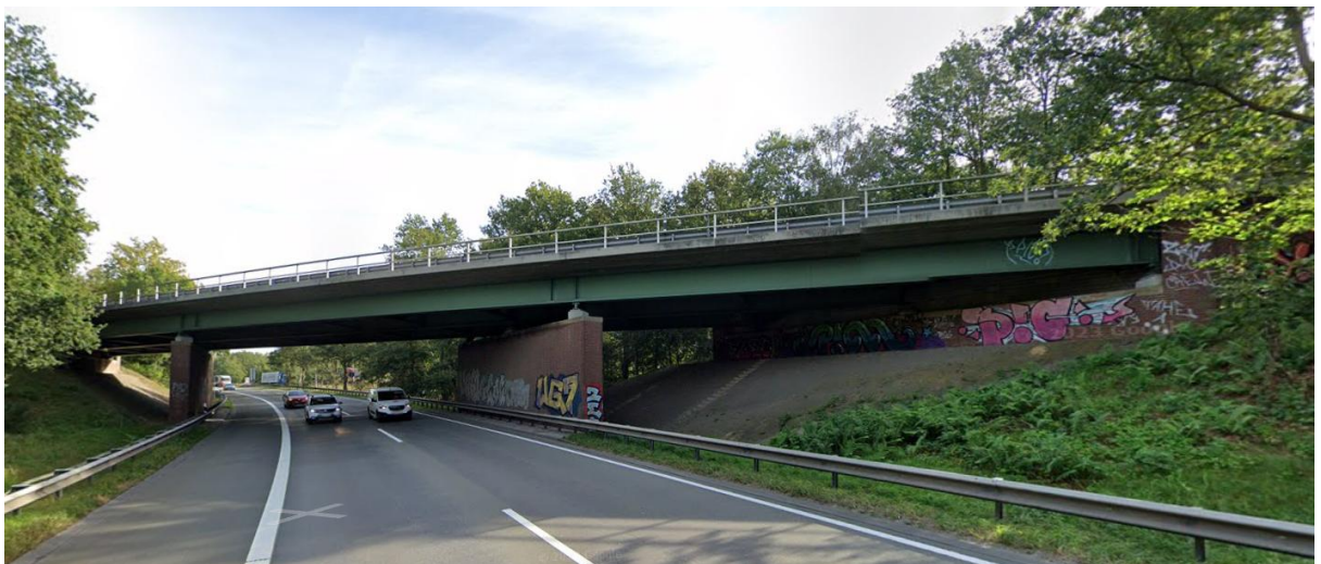
Abb. 8: Seitenansicht BW 435 (Quelle: Google Maps, Stand: 16.03.2026)
